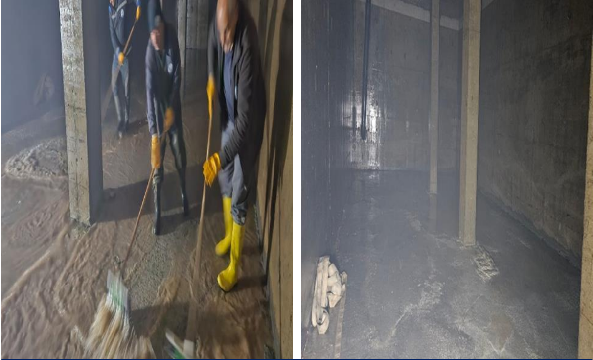
İçme Suyu Tesisleri İç Temizlik Çalışmaları
