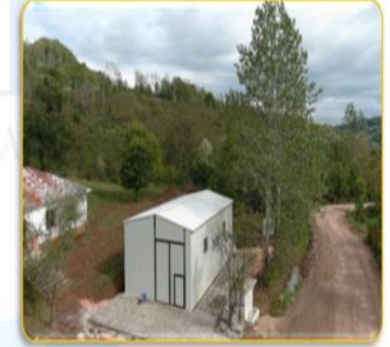
1 adet İçme Suyu Arıtma Tesisi
