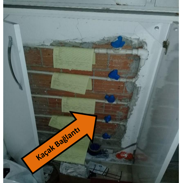
Direkt Bağlantı ile Kaçak Su Kullanımı
