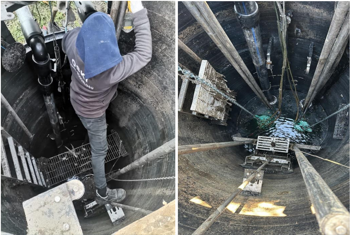
Gülyalı Çikolata Park Paket Atık Su Terfi Merkezi Yenileme Çalışmaları
