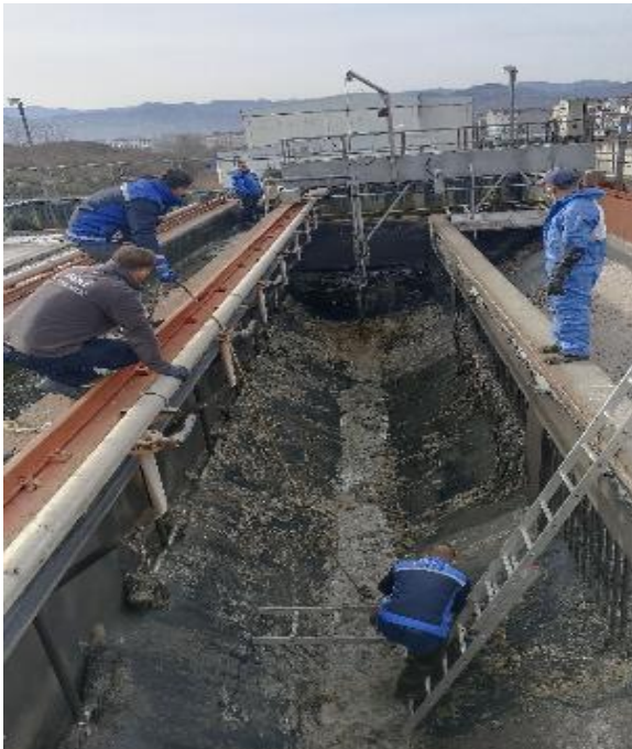
Durugöl Atık Su Arıtma Tesisi Havuz Temizlik ve Bakımları
