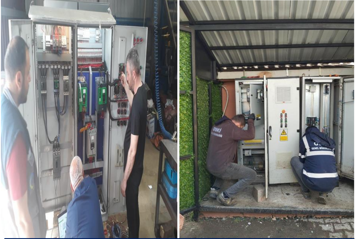
Pano Bakım Onarım Çalışmaları
