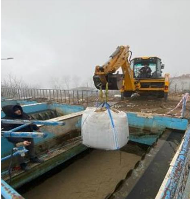
Aybastı Merkez İçme Suyu Arıtma Tesisi Filtre Medyası Değişimi ve Bakımı
