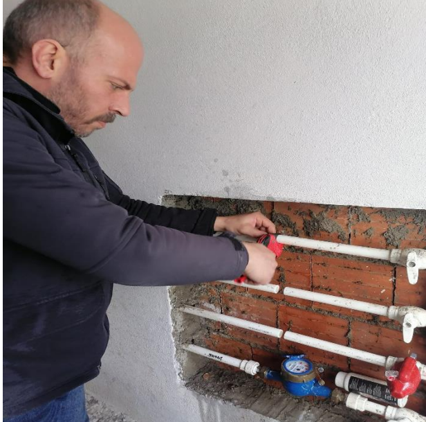
Direkt Bağlantı ile Kaçak Su Kullanımı
