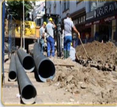
28 km Kanalizasyon Hattı
