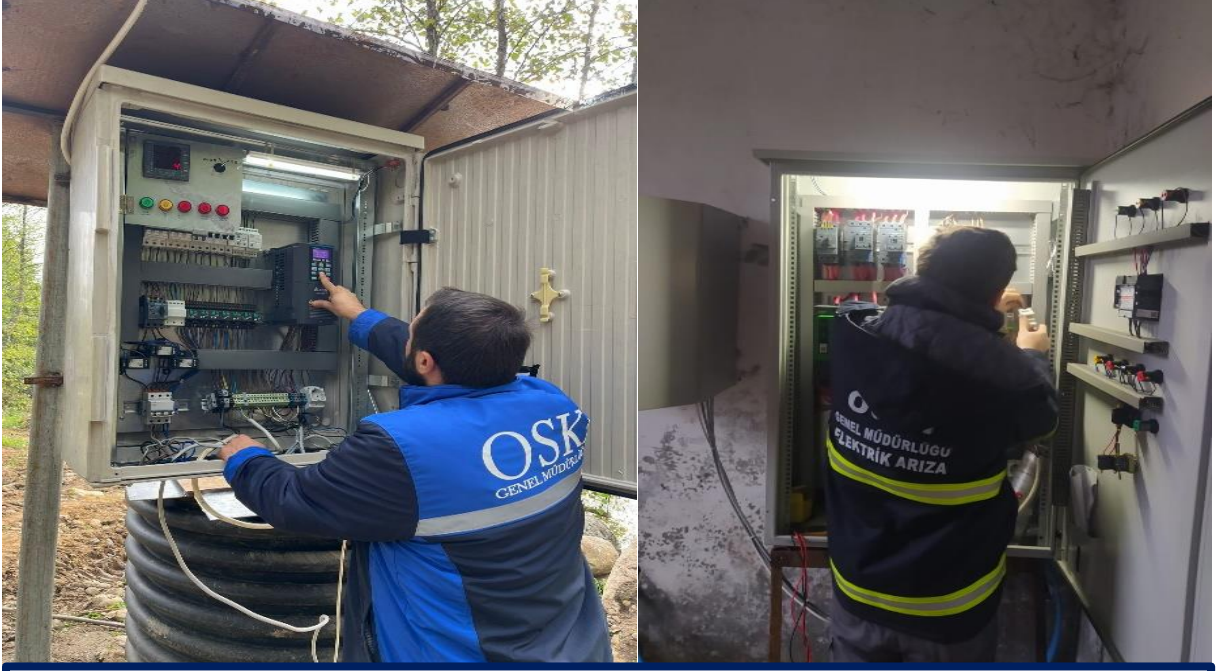
Elektrik Bakım Onarım Çalışmaları
