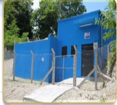
8 adet İçme Suyu Deposu
