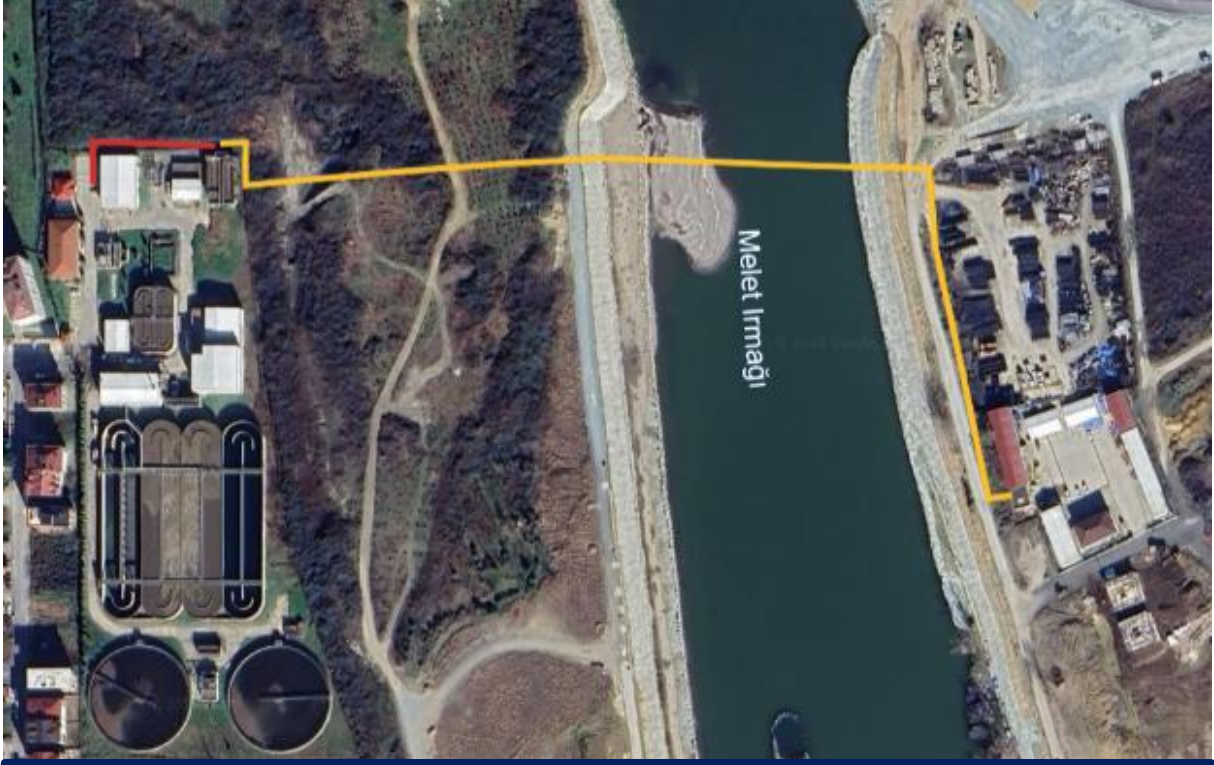
Cumhuriyet Terfi - Durugöl Atık Su Arıtma Tesisi İzgara Binası Bağlantısı
