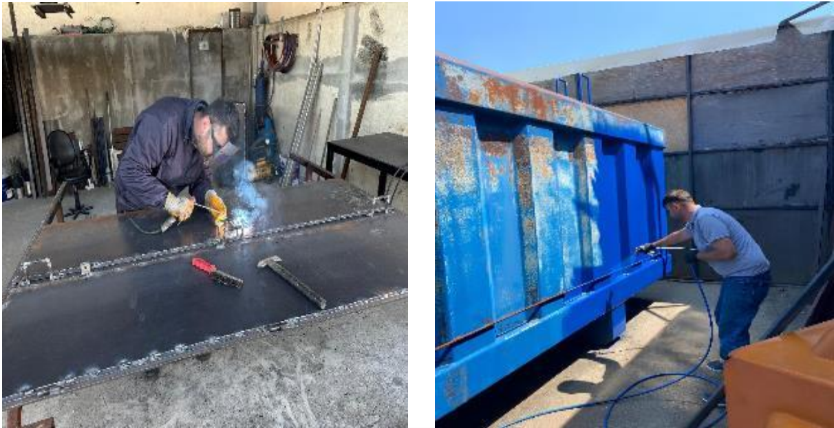
Kaynaklı İmalat ve Bakım Çalışmaları
