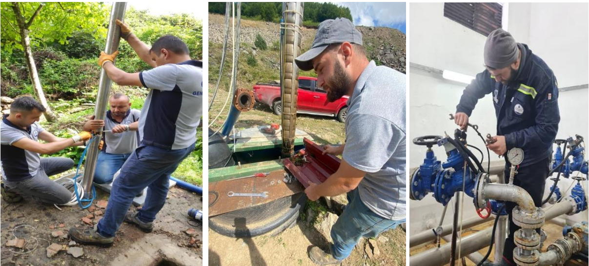
Pompa Bakım Onarım Çalışmaları
