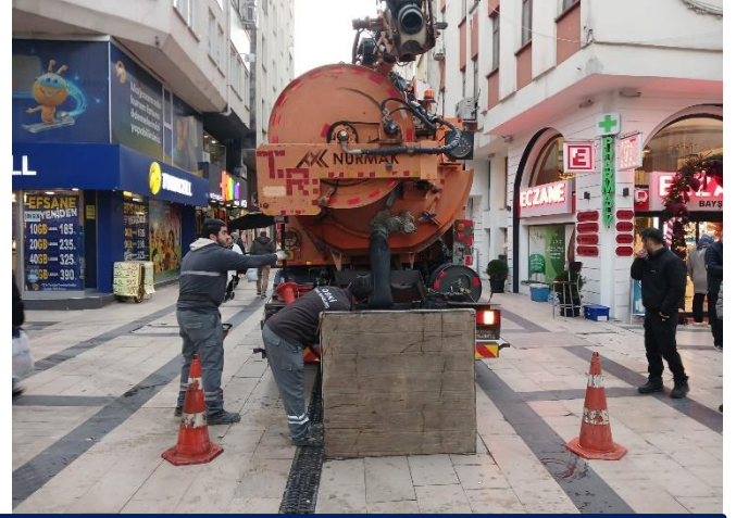
Kuka-Kombine Araçları ile Kanal Açma/Çekme Çalışmaları
