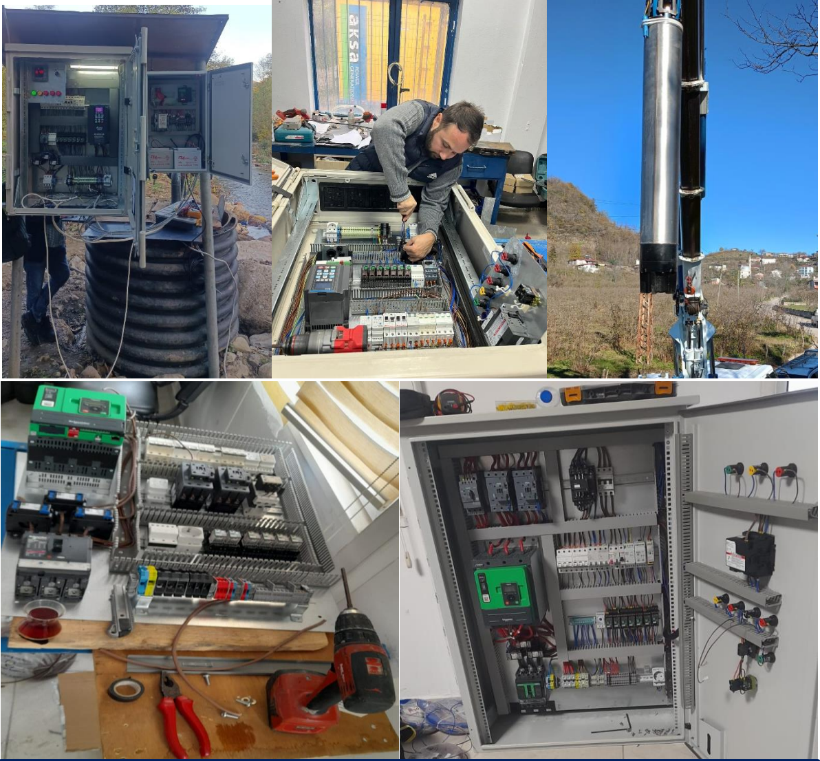
Yeni Pano ve Pompa Kurulum Çalışmaları
