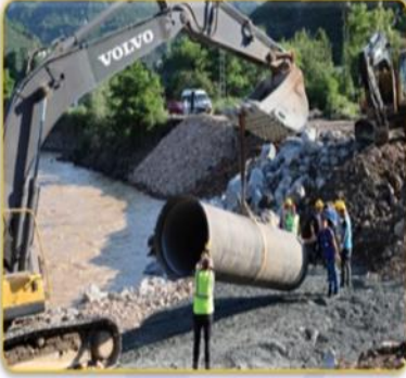
250 km İçme Suyu Hattı
