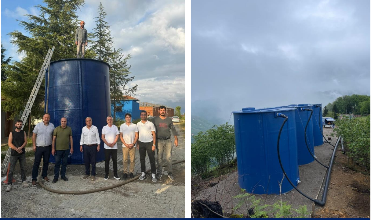
Fiber İçme Suyu Deposu Çalışmaları
