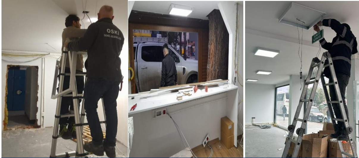
Bina Tesisat Çalışmaları
