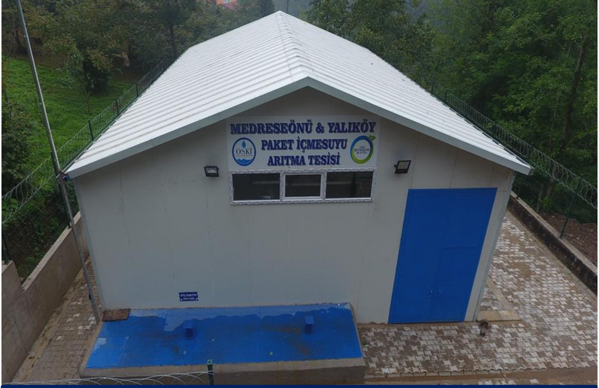
Medreseönü & Yalıköy Paket İçme Suyu Arıtma Tesisi
