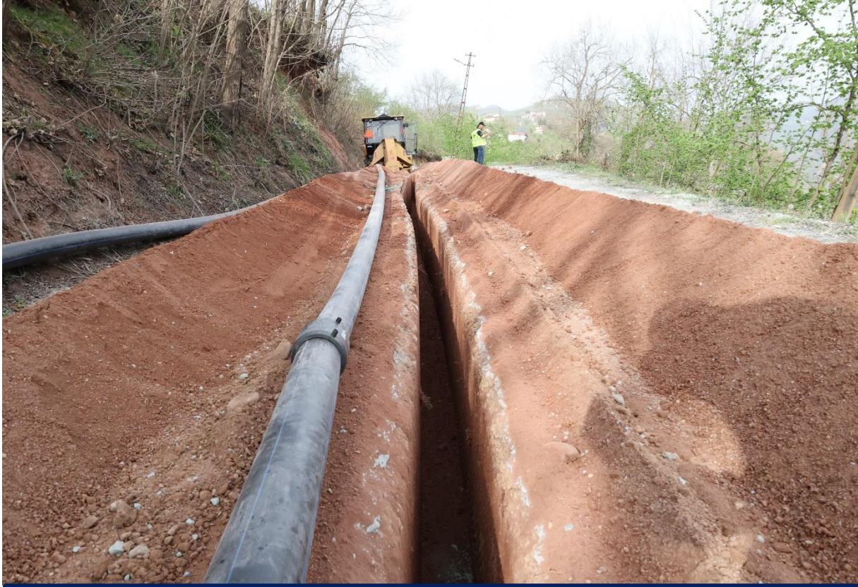
Trencher ile İçme Suyu İnşaatı
