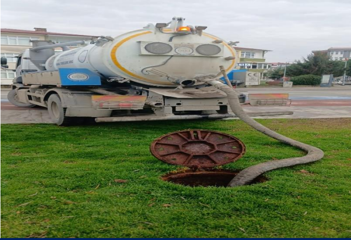
Kuka-Kombine Araçları ile Kanal Açma/Çekme Çalışmaları
