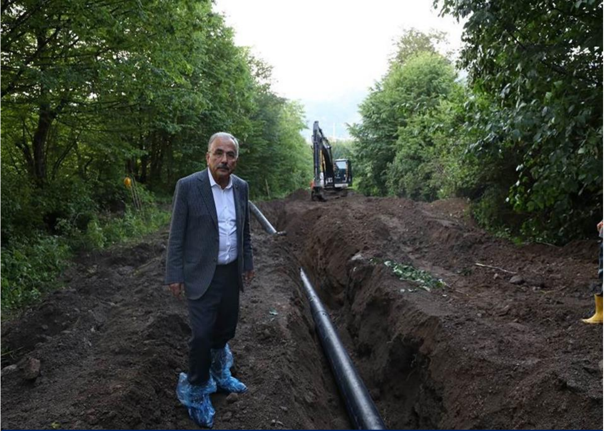
İçme Suyu ve Kanalizasyon İnşaatı
