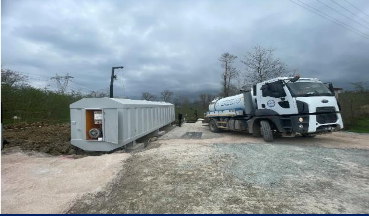
Teyneli Paket Atık Su Arıtma Tesisi
