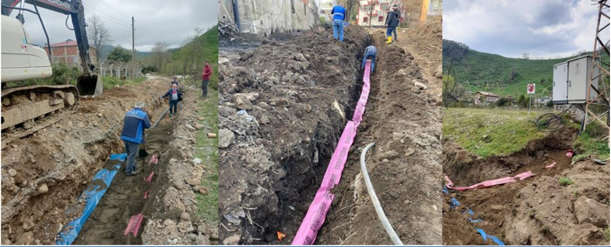
ENERJİ NAKİL HATTI YAPIM ÇALIŞMALARI
