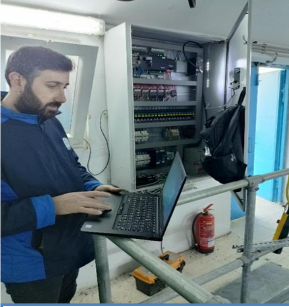
DEPO, TERFİ MERKEZİ SCADA KURULUMU
