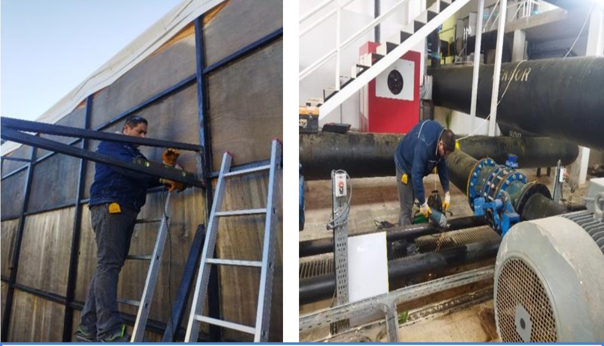
KAYNAKLI İMALAT ÇALIŞMALARI
