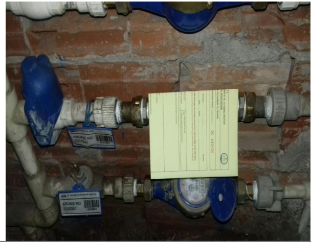
DİREKT BAĞLANTI İLE KAÇAK SU KULLANIMI
