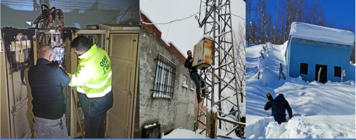
ELEKTRİK BAKIM ONARIM ÇALIŞMALARI
