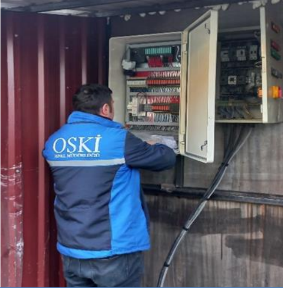
ARITMA TESİSİ SCADA KURULUMU
