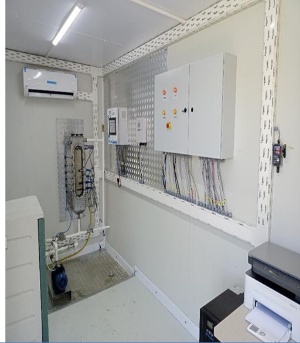
SÜREKLİ ATIK SU İZLEME SİSTEMİ KURULUMU
