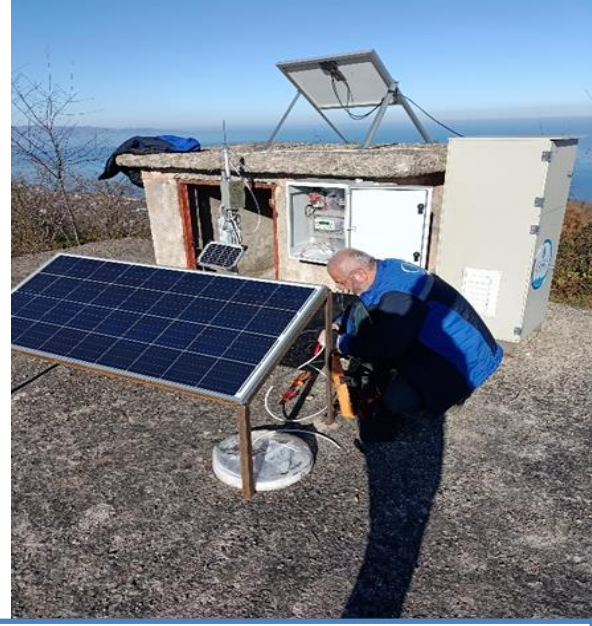
DEPO, TERFİ MERKEZİ SCADA KURULUMU
