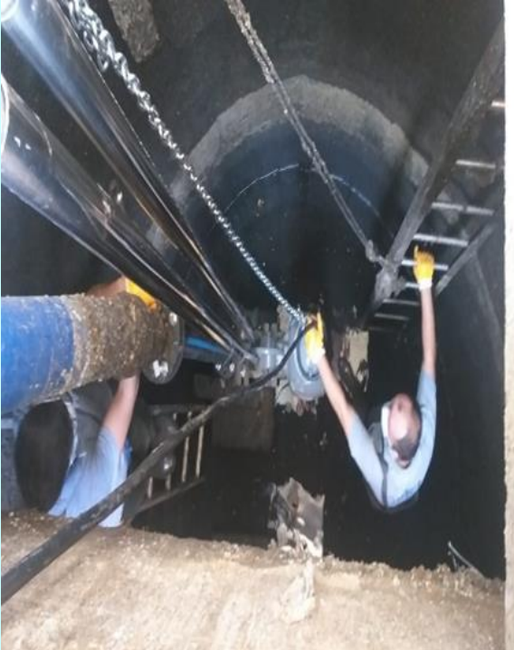
ATIK SU TERFİ MERKEZİ POMPA YENİLEME ÇALIŞMALARI
