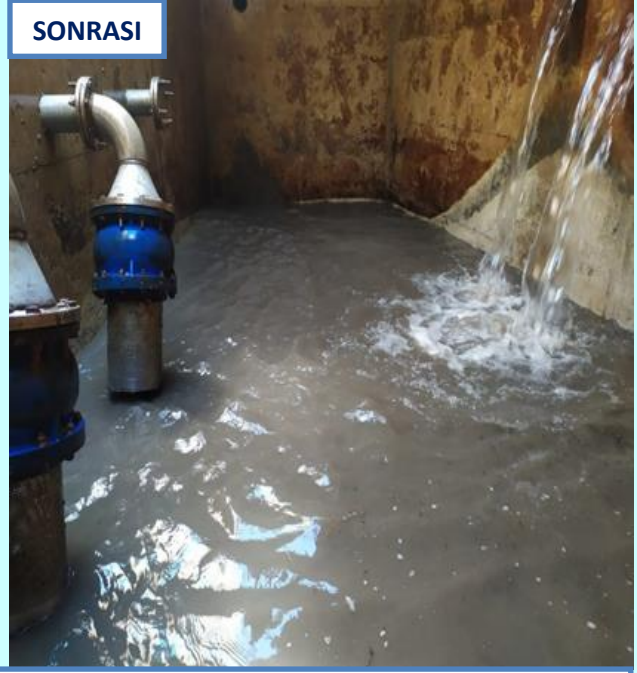
AKKUŞ KEMİKGERİŞ İÇME SUYU TERFİLİ DEPOSU İÇ TEMİZLİĞİ
