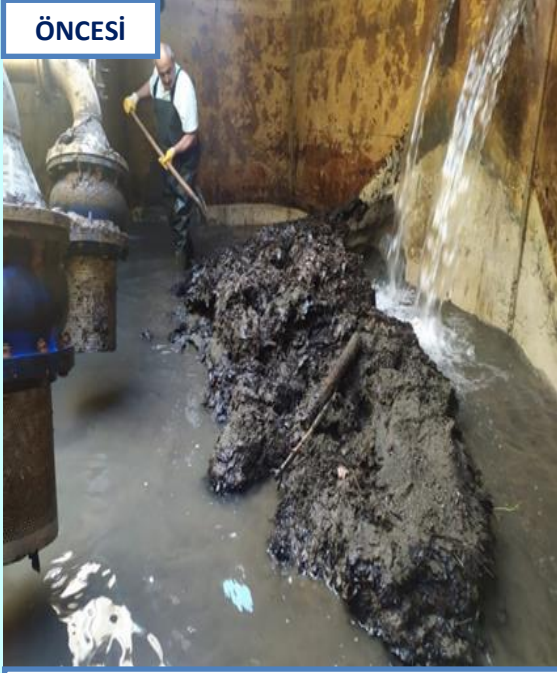
AKKUŞ KEMİKGERİŞ İÇME SUYU TERFİLİ DEPOSU İÇ TEMİZLİĞİ
