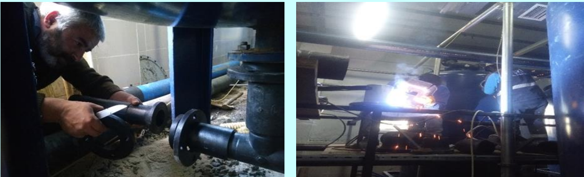
TESİS REVİZYON ÇALIŞMALARI
