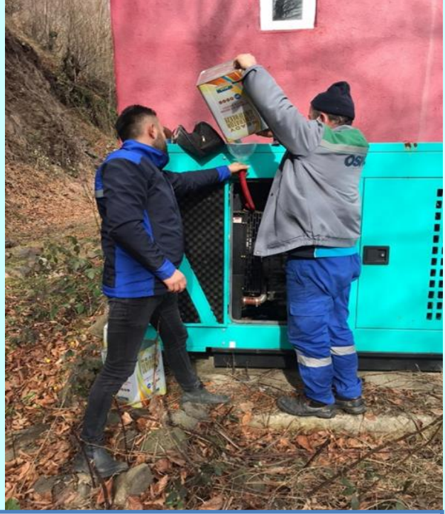
JENERATÖR BAKIM ONARIM ÇALIŞMALARI
